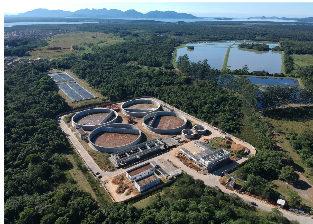
Imagem: Nova ETE Jarivatuba (à esquerda, em construção) e, ao lado, a Estação de Tratamento de Esgoto atual, do tipo Lagoas de Estabilização.
