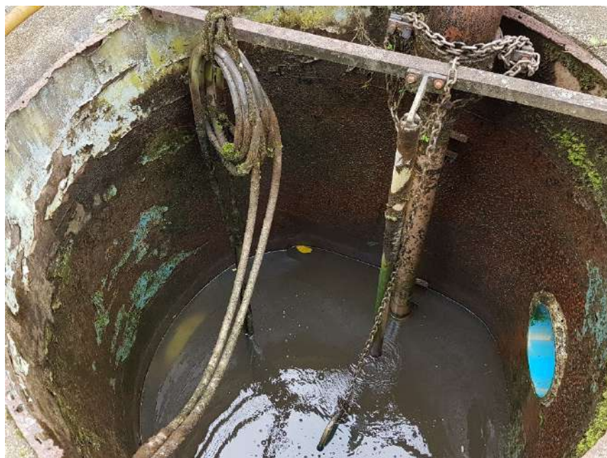
Figura 9 – Poço de recebimento e bombeamento da água de lavagem dos filtros
