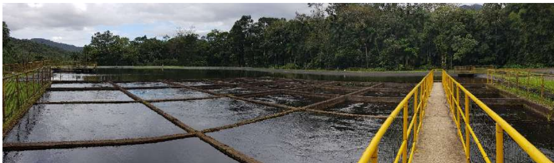
Figura 6 – Tratamento (floculação e decantação)
