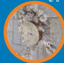
Água da chuva conectada de forma irregular à rede coletora causa extravasamento de esgoto
