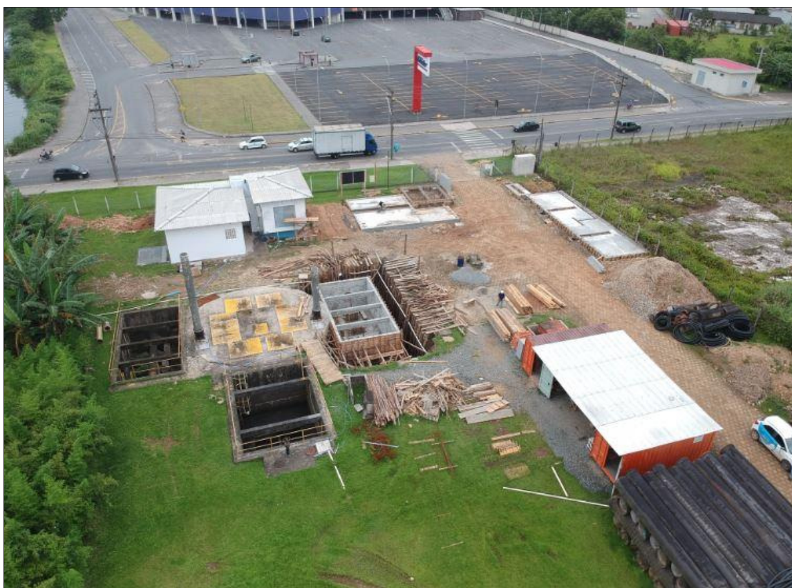
Foto: Obra de adequação da estação elevatória de esgoto da Rua Florianópolis Crédito imagem: Bruno Gentil
