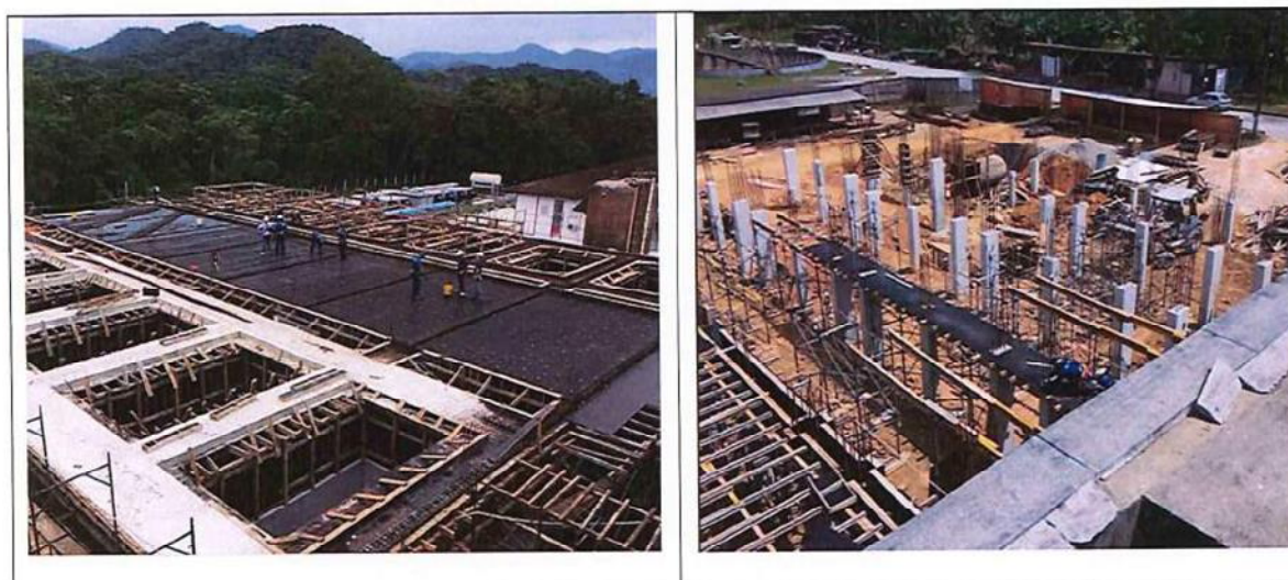
Foto: Ampliação ETA Cubatão – Flocodcantador Filtros - 12/2017
