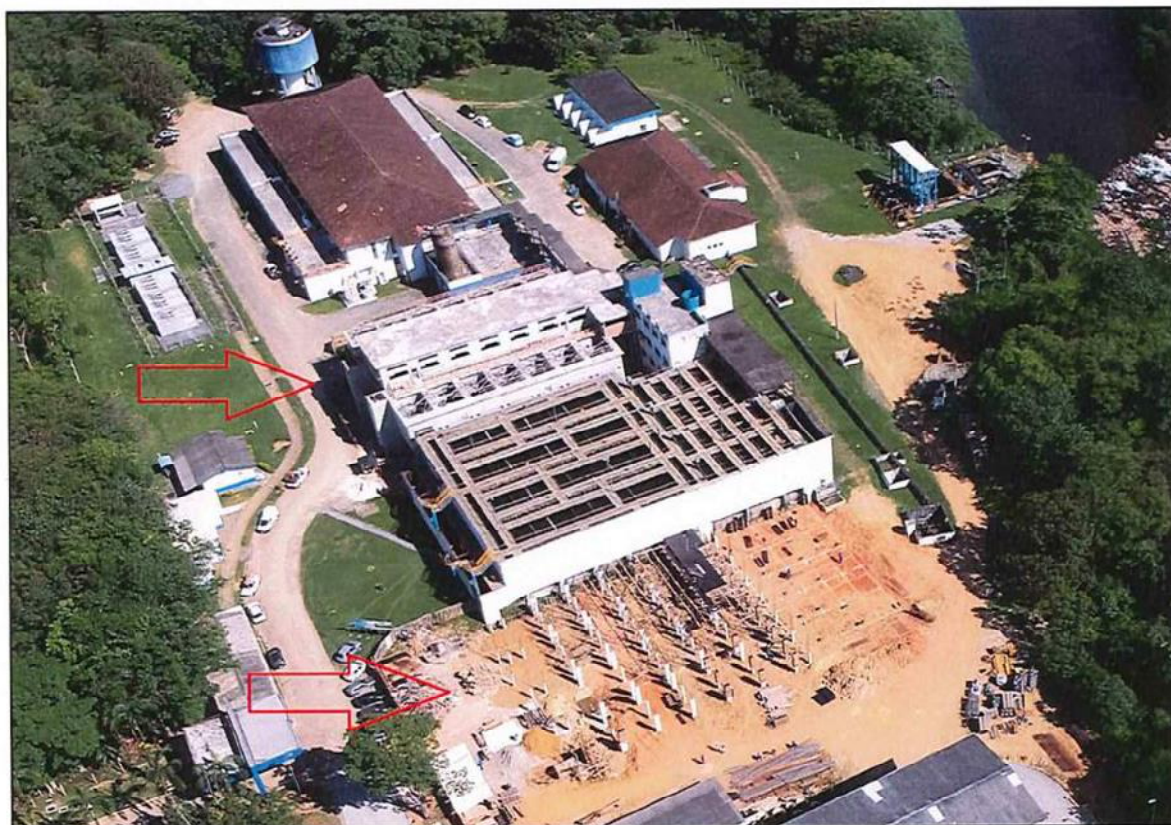
Foto: vista aérea - Ampliação ETA Cubatão - em 12/2017.
