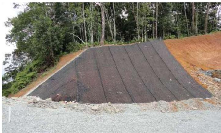
Figura 20 – Geotêxteis instaladas em talude.
